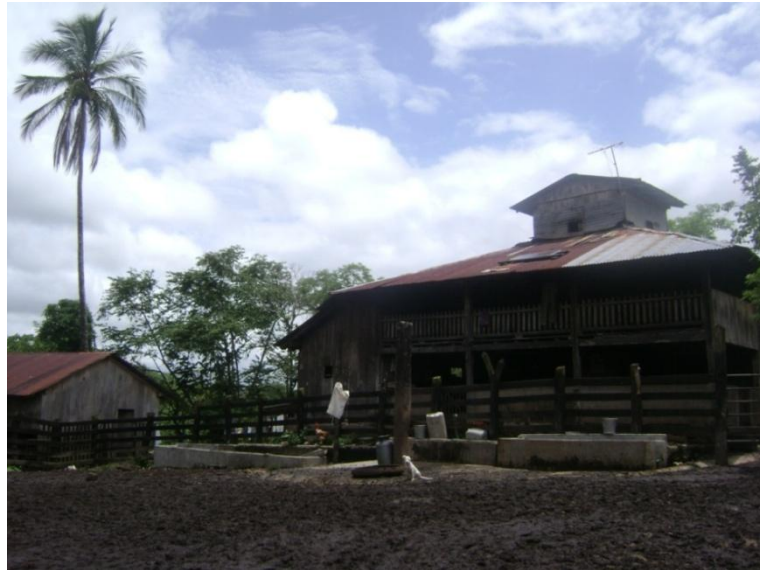
Figura 3. Casa de la finca.
