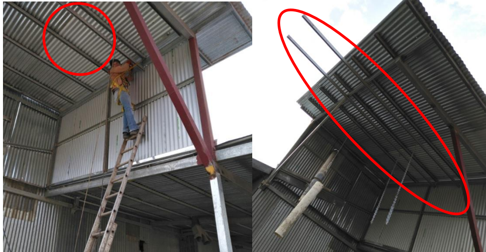
Figura 7. Construcción de líneas de vida.
