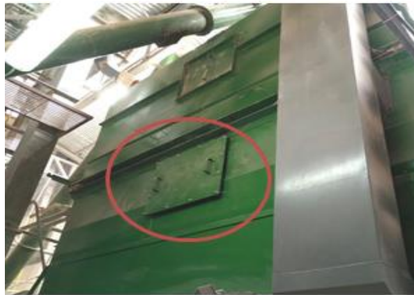
Figura 3. Abertura en mezcladora para facilitar proceso de limpieza e inspección.
