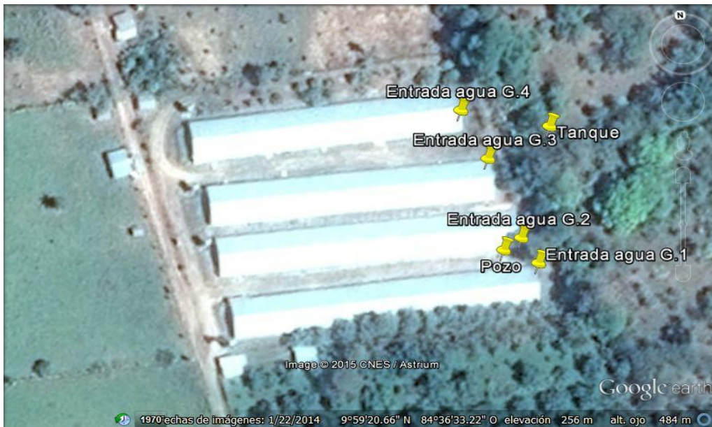
Figura 6. Diagrama de la ubicación de la fuente y los tanques de la Granja Las Niñas.
