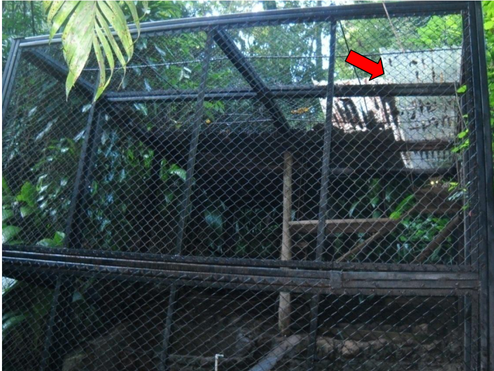
Figura 48. Cobertura de techo en el recinto.
